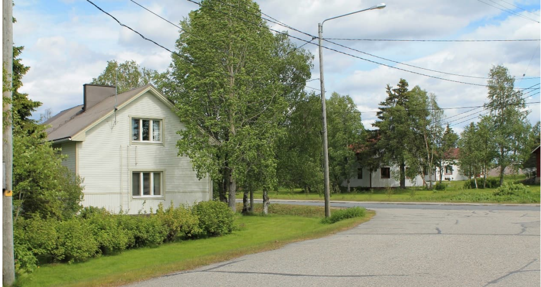
Kuva 14. Perinteistä rakennuskantaa Lahenrannantien varrelta (FCG / Mari Lampinen)
